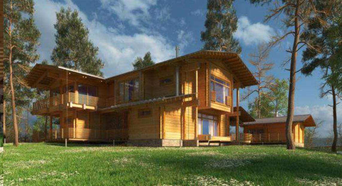
Наружная отделка зданий: цоколь - натуральный камень, стены первого и второго этажей - клееный брус с пропиткой и окраской, окна и витражи из теплого деревянного профиля, заполненного двухкамерным стеклопакетом. Покрытие кровли - металлическая фальцевая серого цвета. Ограждения террас и крылец - деревянные реечные.
